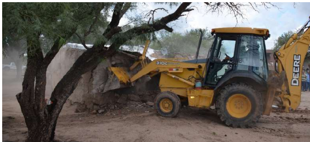
Destrucción vivienda rancho
